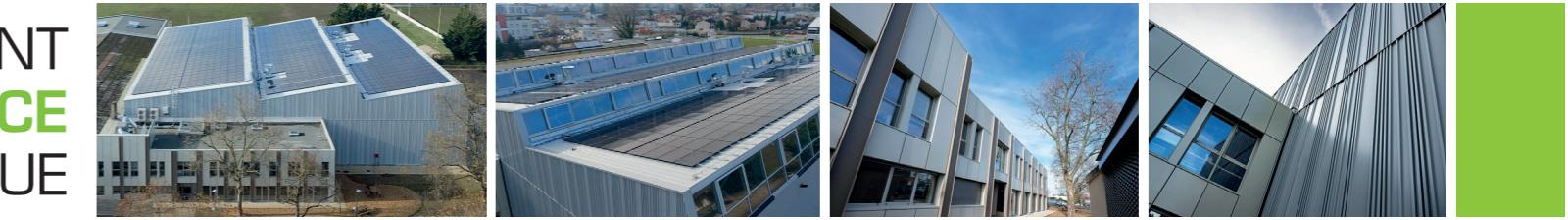
Eclairage naturel par verrières et sheds. Sources LED avec capteurs présence et luminosité. Panneaux photovoltaïques 450 Kwc. Façade bureaux en ossature bois. Habillage calettes aluminium recyclés. Plancher bois CLT.
